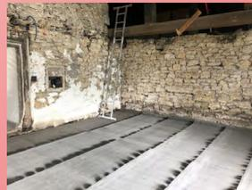
Pose d'une membrane pare-radon sans assurer l'étanchéité des plinthes à la jonction mur / dalle
