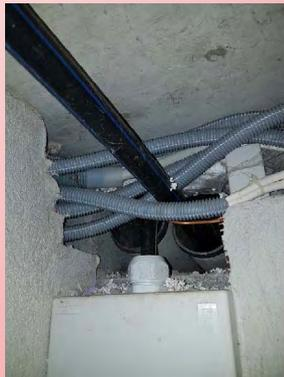
Présence de points d'infiltration du radon dans le bâtiment
