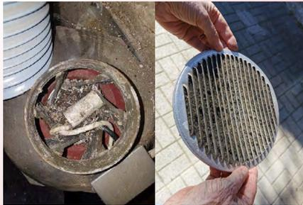
Mangelhafter Unterhalt von Gittern und Ventilatoren
