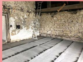
Verlegung einer Radonfolie auf dem Boden ohne Verbindung zu den Wänden und/oder Verlegung auf den Wänden
