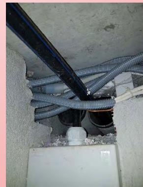
Drainagesystem für Radon ohne Ventilator
