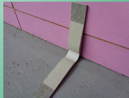
Verlegung der Radonsperre am Boden-Wand-Anschluss
