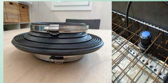
Verwendung von Spezialmuffen bei durchgehenden Kanälen
