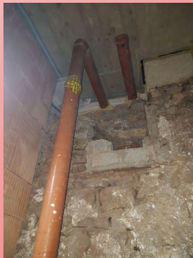
Posa di sola membrana antiradon sul pavimento senza coesione alle pareti e/o posa sulle pareti
